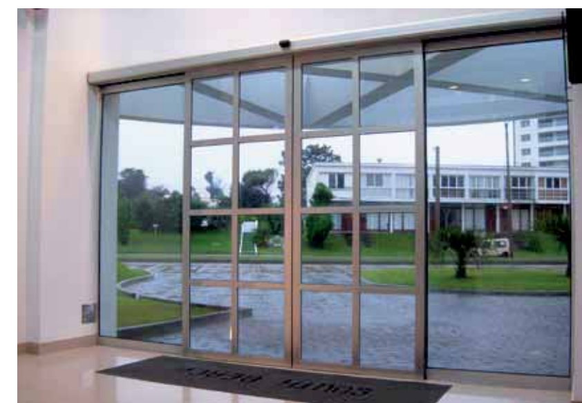
Sas d'entrée à deux portes automatiques à ouverture centrale. Secteur hôtelier.
