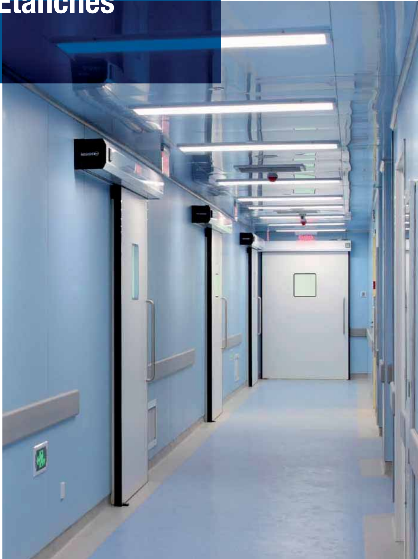
Portes étanches coulissantes. Zone chirurgicale dans un hôpital.
